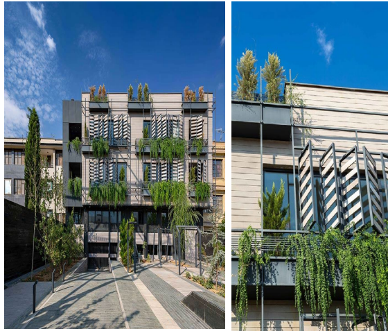
تصاویر ۲۲-۲۳: نمای جنوبی، استفاده از بازشوهای آکاردئونی مشبک متحرک و پوشش گیاهی در جهت کنترل دید و نور جنوب
